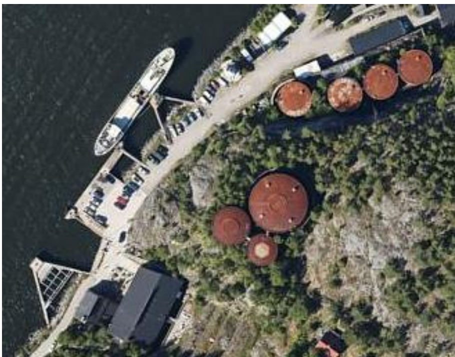
Figur 8. Befintliga oljebryggor och befintlig kaj som ska rivas.
