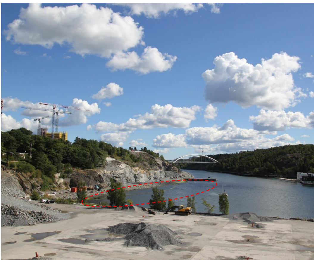
Figur 6. Läge för strandlinje längs Kvarnholmens södra strand där Södra kajen och tryckbank i vattnet planeras. Området sträcker sig fram till den befintliga betongpiren som ska rivas. Nya dubbla geotextilskärmar kommer att läggas längre ut inför att planerade arbeten påbörjas. Fotografiet är taget från det område där detaljplan 6 planeras. Längst bort syns den bro som byggts mellan Kvarnholmen och Ryssbergen (Foto: WSP).
